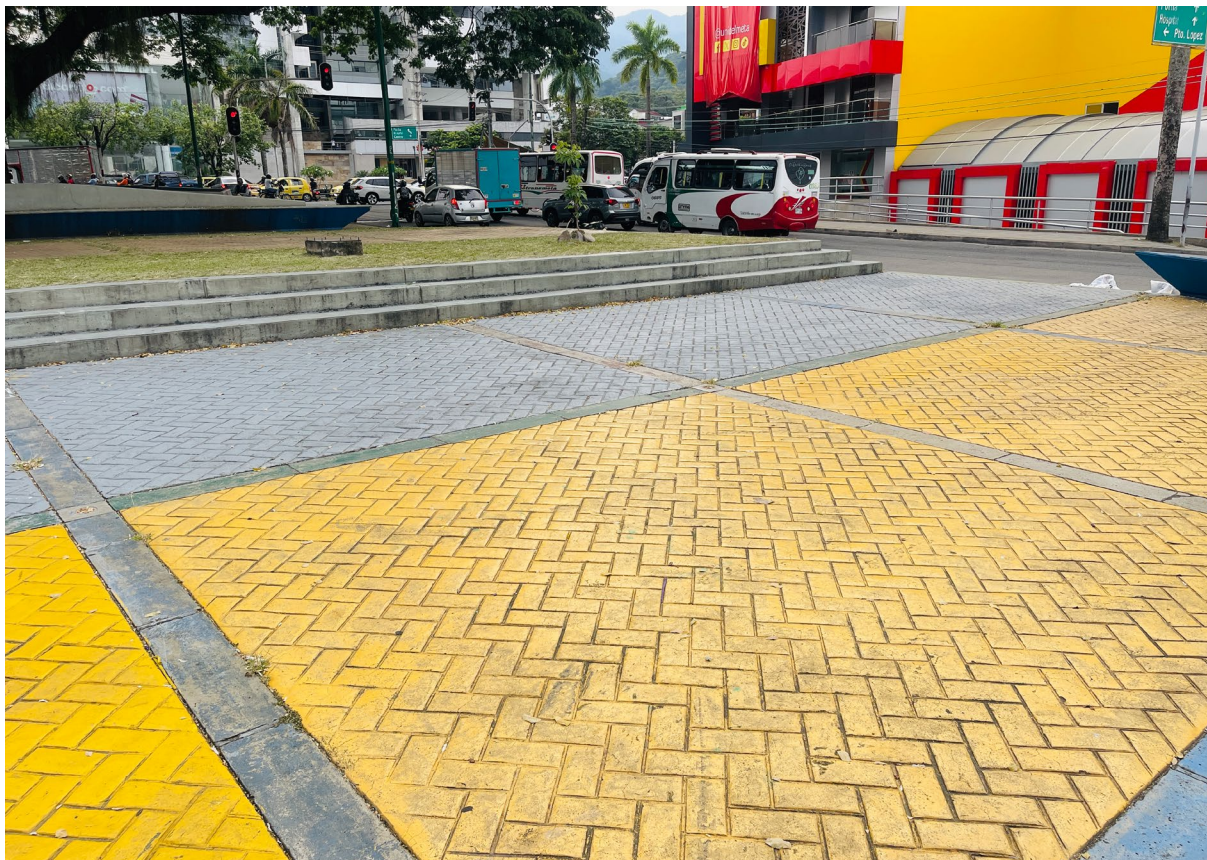
Figura 4. ▲ Tramo interno con desnivel y discontinuidad en el pavimento
